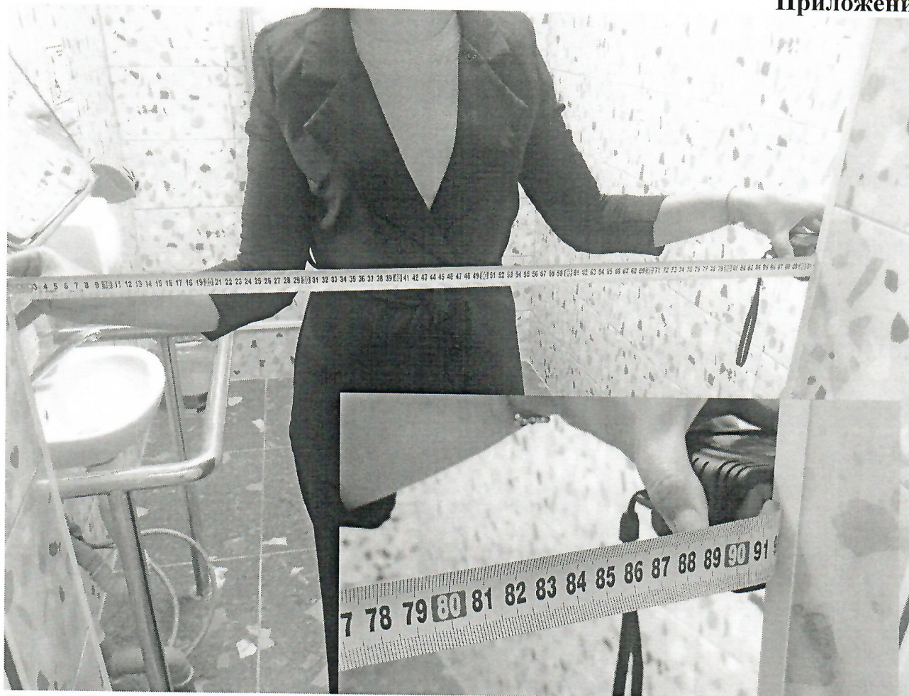
Дверной проем расширен до 0,9 м согласно требованиям установленных СНиП.
