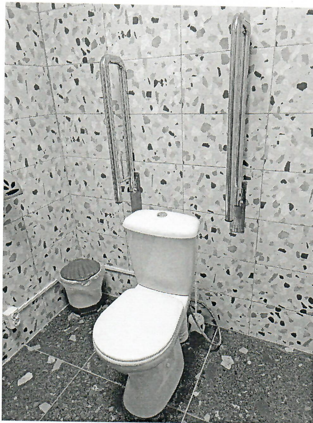
В туалетной комнате, установлены откидные опорные поручни
